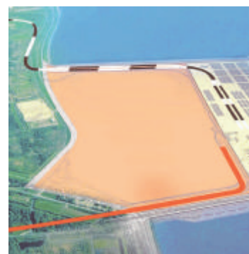
Der Jade-Weser-Port wird für Containerschiffe mit 16,5 Meter Tiefgang ausgelegt
